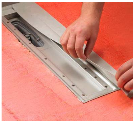
4. Montering av Seal-Strip
