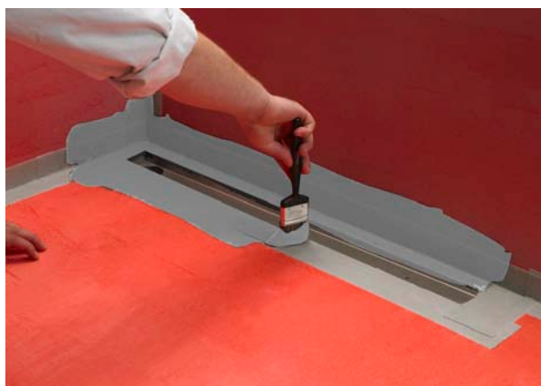
6. Påföring av Alfix Tätningsmassa.
