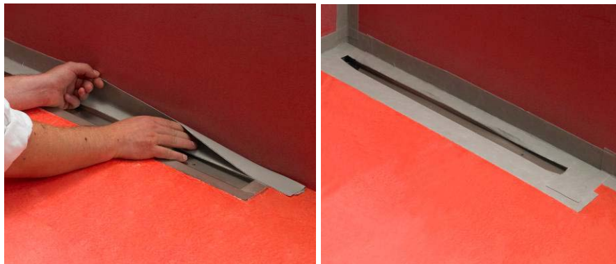
4. Montering av Seal-Strip
