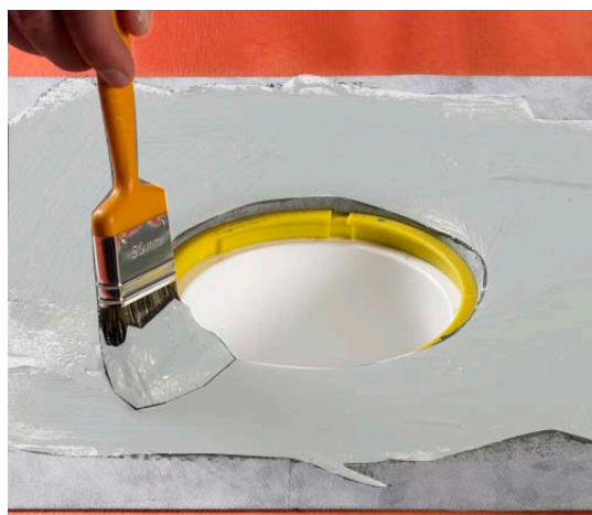
9. Påföring av Alfix Tätningssmassa.
