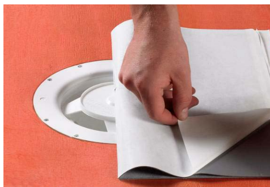
6. Montering av Alfix Tätskiktsduk.
