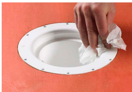
4. Rengör brunnens säte/fläns och avfetta med till exempel aceton.
