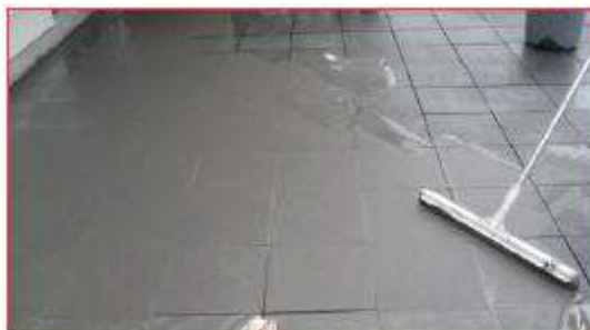
Fogmassan hälls ut på den keramiska ytan
