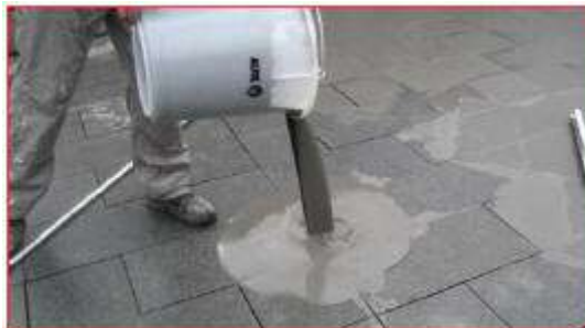
Fogmassan hälls ut på den keramiska ytan
