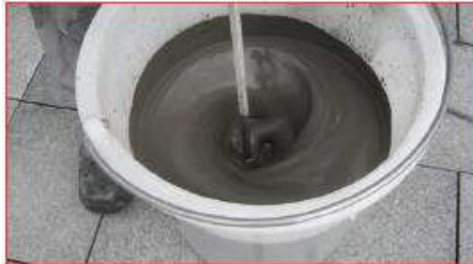
Cerafill 15 quick blandat med 0,24 liter vatten pr. kg. pulver
