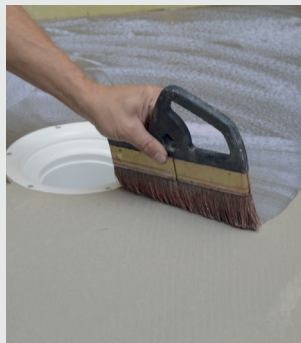
Reglering av sugförmåga Försegling med VT-hörn-/remсор
