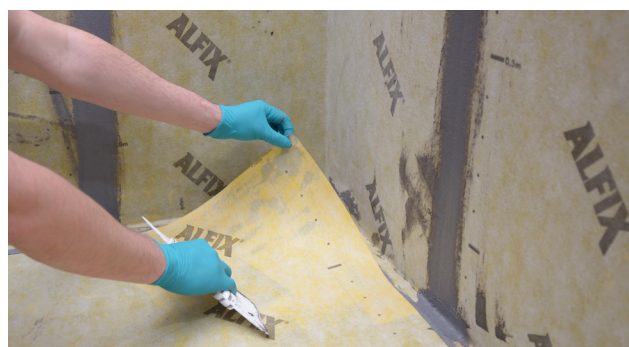
Montering av våtrumsmatta på golv
