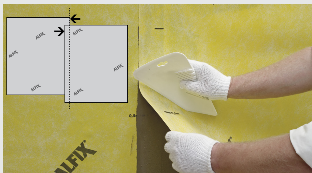
Montering av våd omlott vid skarvar
