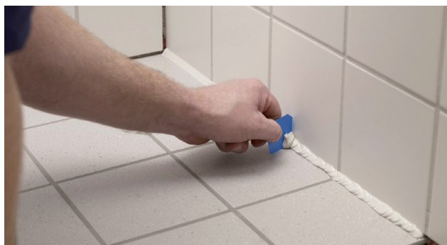
Överskjutande Alfix Silicon skrapas bort
