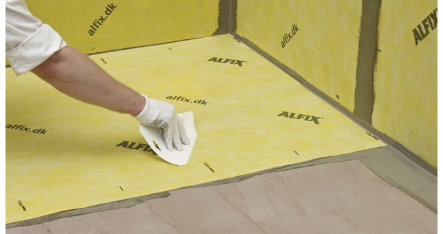
Montering av våd på golv
