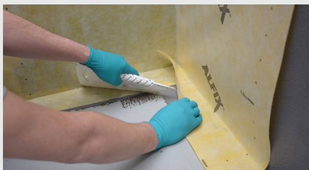
Montering av våtrumsmattan
