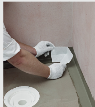
Reglering av sugförmåga Försegling med VT-hörn-/remсор
