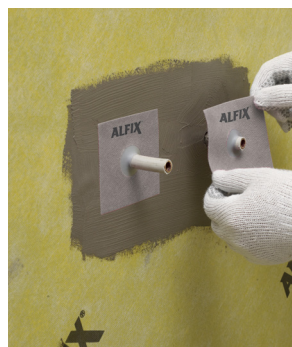
Montering av VT-Rörmanschetter
