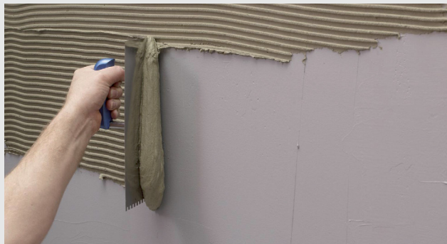
Påföring av fästmassa
