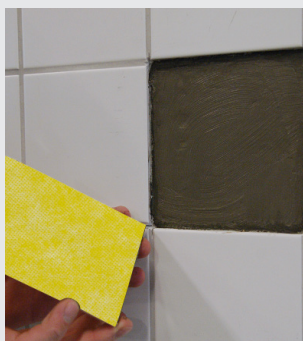
Ytan penslas med Alfix 2K Tätningsmassa och tillpassa/montera en bit av Våtrumsmatta Pro
