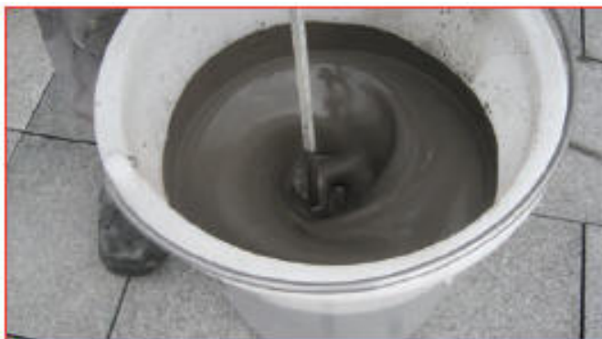
Cerafill 15 quick oprørt med 0,24 liter vand pr. kg. pulver
