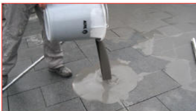
Fugemassen hældes ud på fliseoverfladen.
