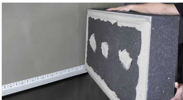
Montering af isoleringsplade
