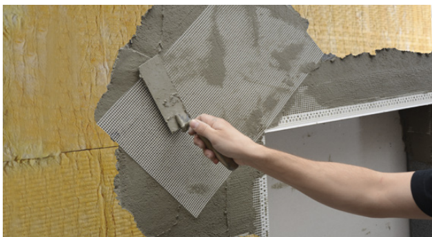
Montering af armeringsnet ved vinduesfals
