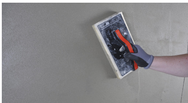
Filtsning af overfladen
