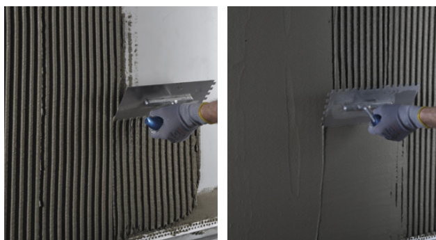
Påføring af Alfix DuraPuds 710 / 810 med tandspartel
