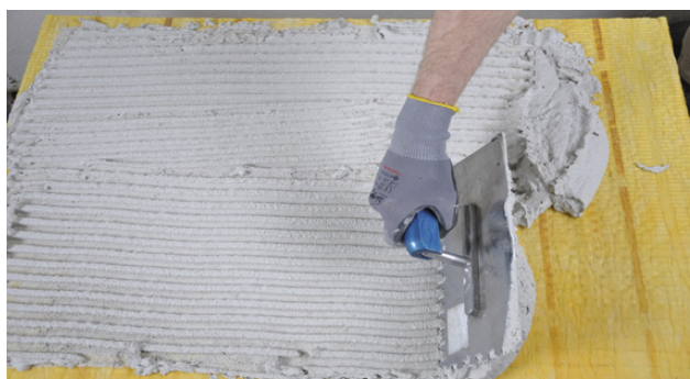
Påføring af Alfix DuraPuds 830 med tandspartel
