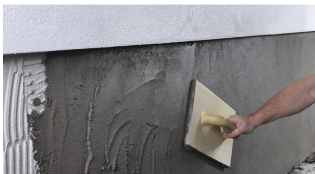
Pudsning af sokkel med pudsebræt
