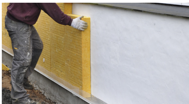
Montering af mineraluldplader min. 15 cm over terræn
