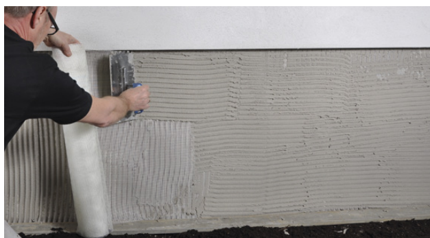
Montering af armeringsnet i Alfix DuraPuds 615
