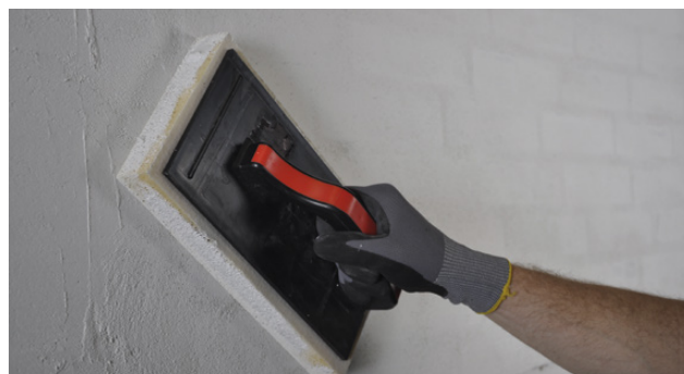
Filtsning af overfladen
