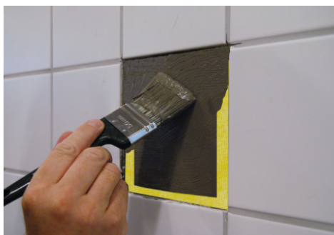
Ytan penslas med Alfix 2K Tätningsmassa
