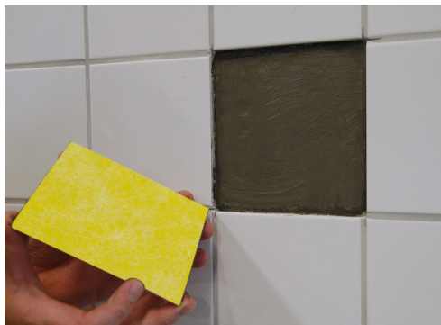
Tillpassa och montera en bit av Våtrumsmattan
