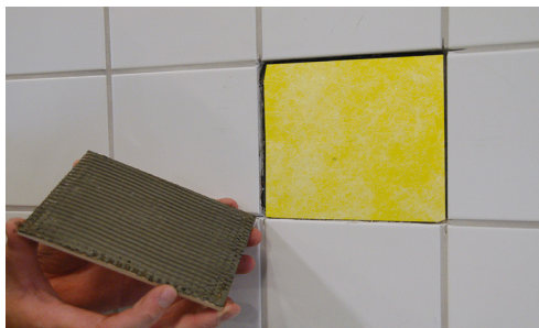
Ny platta monteras
