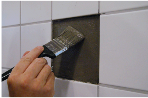
Ytan penslas med Alfix 2K Tätningsmassa
