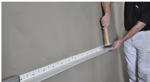
Montering av Alfix Startvinkel Flex
