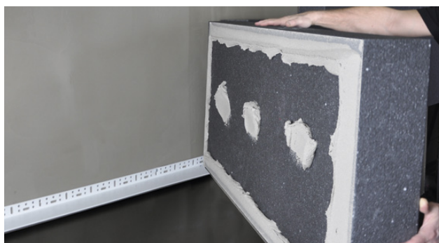
Montering av isolasjonssplater
