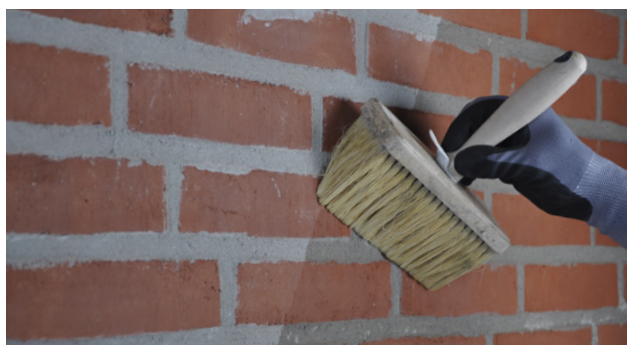
Forvanning av vegg
