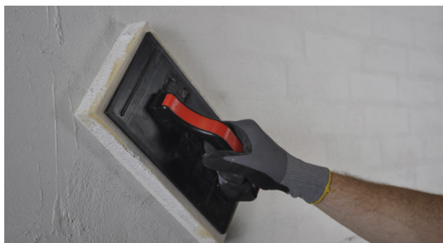
Filsing av overflaten
