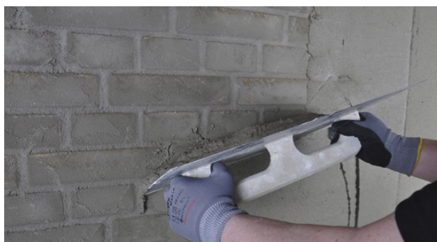
Påføring av DuraPuds 710
