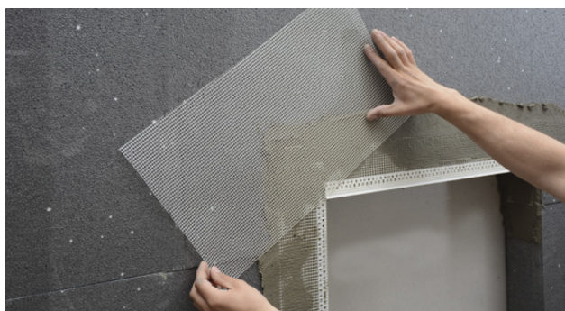
Tilpasning av armeringsnett ved vindusfals
