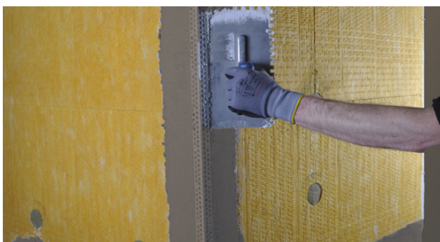
Montering av hjørnelister
