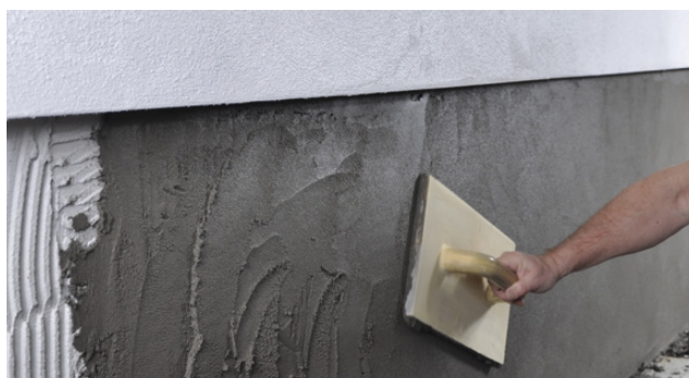
Pussing av sokkel med pussebrett
