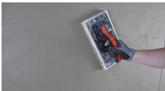
Filsing av overflaten
