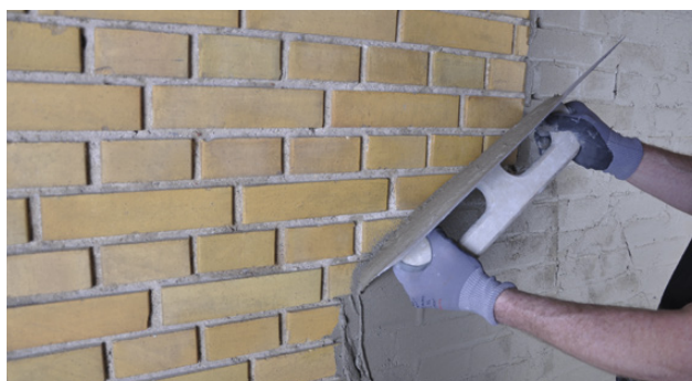
Påføring av kontaktlag med DuraPuds 710
