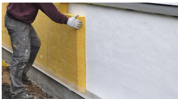
Montering av mineralullplater min. 15 cm over terrenget
