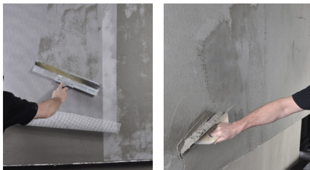
Montering av nett med minst 10 cm overlapping og påføring av et heldekkende lag med Alfix DuraPuds 810
