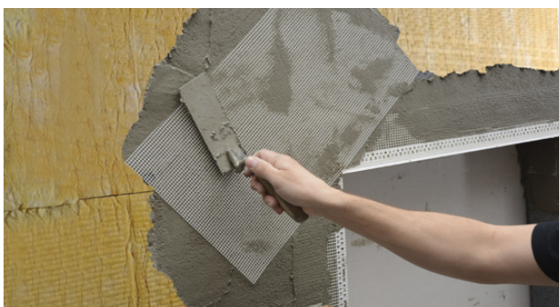
Montering av armeringsnett ved vindusfals
