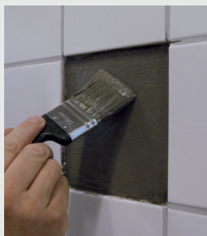
Tætningsmassen påføres underlaget, og flisen monteres
