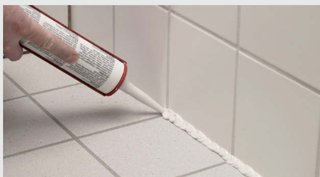
Fyldning med siliconebaseret fugemasse
