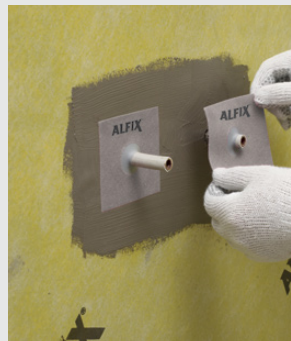
Montering af VT-Rørmanchetter
