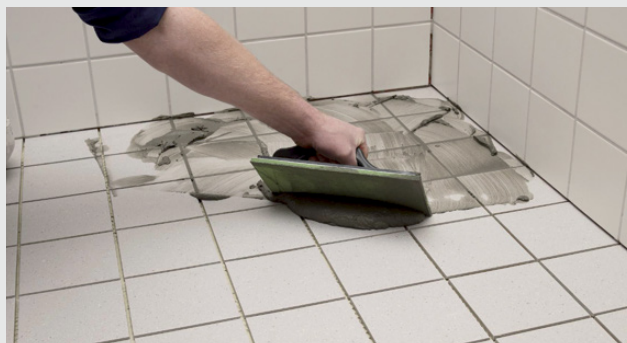
Påføring af cementbaseret fugemasse
