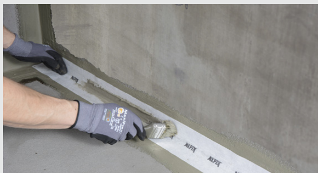
Metode 1: Montering af Alfix VT-Tætningsbånd
