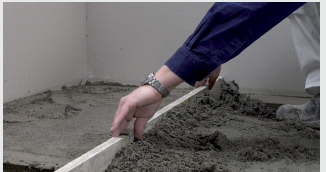
Støbning på træbjælkelag
