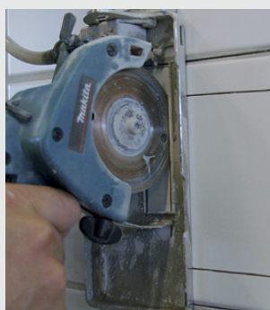
Skær et spor langs flisekanterne. Fjern forsigtigt flisen
