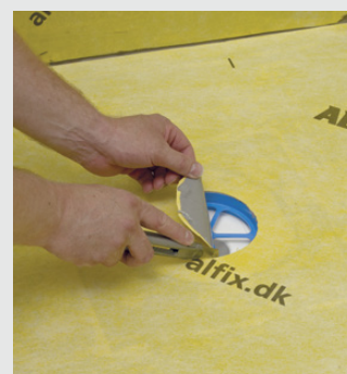
2: Udskæring med skabelon ved afløbsmanchet Type H
