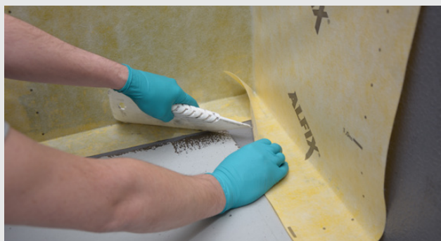
Metode 2: Montering af banemembranen
