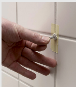
Montering af Rawlplug og montering af skrue
