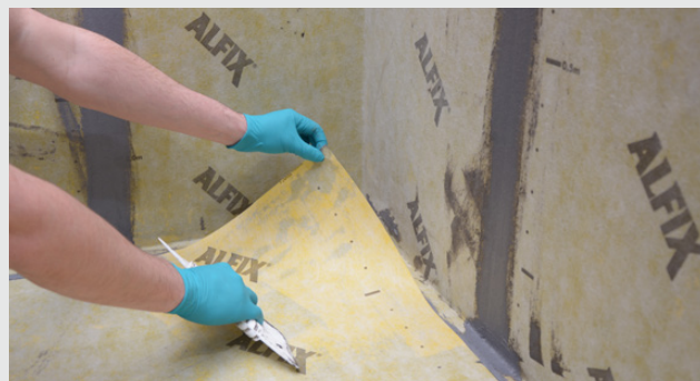
Montering af banemembran på gulv
