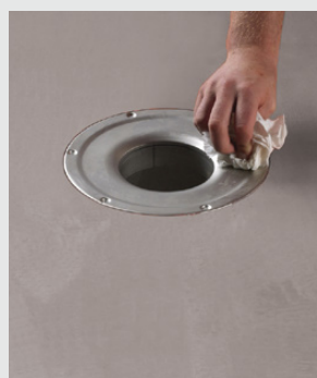
Rengøring af afløbets flange
