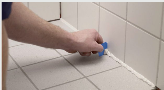
Overskydende fugemasse fjernes
