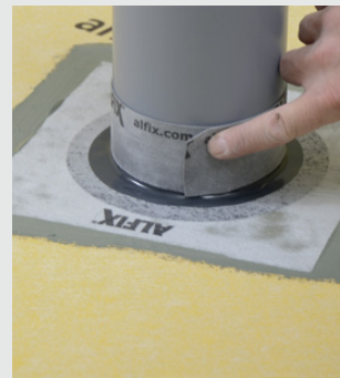
Forstærkning med Seal-Strip ved vandbelastede rør
