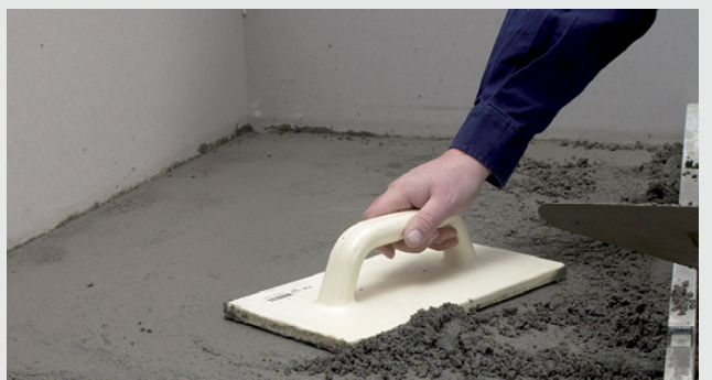
Udglatning med fugebræt
