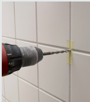
Bor et hul og fyld det med Alfix M-Silicon
