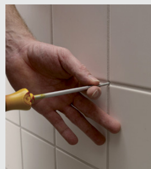
Montering af Rawlplug og montering af skrue
