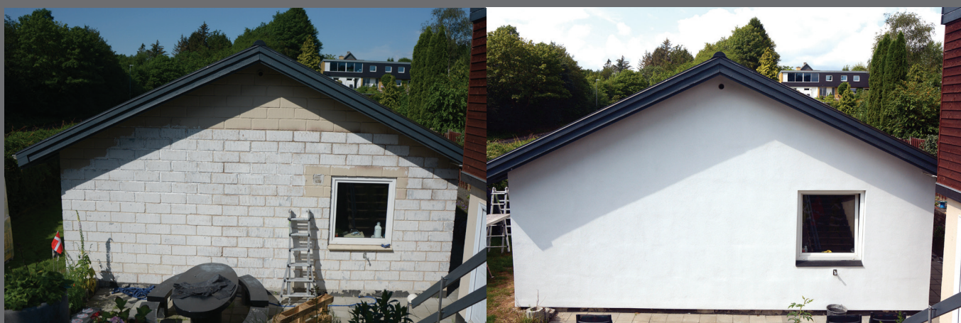
Syddjylland - DuraTherm complete 50 mm med DuraPuds 804 hvid som slutpuds
