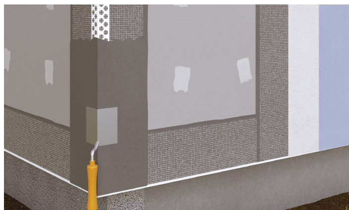
Hjørnelistens armeringsnet trykkes ind i armeringspuds
